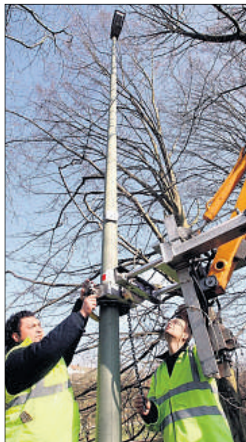
Erzeugen Wind, der keiner ist: Selim Gür und Thorsten Reiz (von links) prüfen einen Laternenmast in der Aue.
