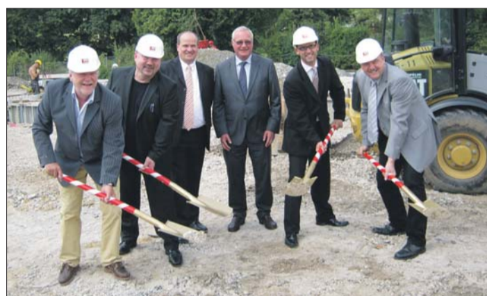
Der DRK-Kreisverband Büdingen vollzog den ersten Spatenstich seiner neuen Rettungswache und Verwaltungsräume. DRK-Geschäftsführer Andreas Abert setzt mit dem Kreisvorstand auf einen Neubau »als finanziellen Kraftakt«. Eine Alternative habe sich angesichts der maroden Technik des alten Gebäudes nicht ergeben. Mit der Fertigstellung der neuen Rettungswache wird im Sommer 2012 gerechnet. Im Foto von links Architekt Hans-Werner Gierhardt, Kreisvorsitzender Dr. Christian Günther, Projektleiter Roger Schütz, Bürgermeister Erich Spamer, DRK-Geschäftsführer Andreas Abert und 1. Stadtrat Manfred Hix beim ersten Spatenstich.
